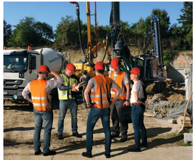
Besprechung der Koordinationsmaßnahmen auf der Baustelle
